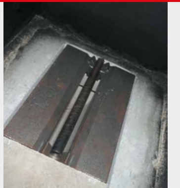
BRUCIATORE GHISA/CERAMICA CAST IRON/CERAMIC BURNER BRÛLEUR EN FONTE/CÉRAMIQUE
